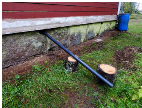
Bastuvattnet leds ut genom kattluckan. Under 2022 skall avledningsröret omfor- mas så att det löper med terrängen in i ett stenröse.
