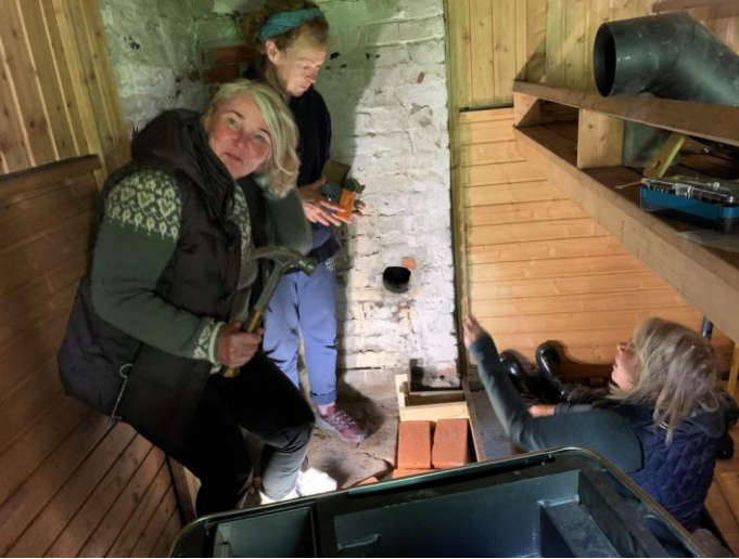
Muottilautoituksen tekoa kiukaan alle, kuva Harry U.
