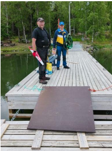
Laiturilla tehtiin pieniä kunnostustöitä. Jatkopalan ja päälaiturin väliin rakennettiin kulkuluska ja laiturin kiinnityksiä vahvistettiin.
