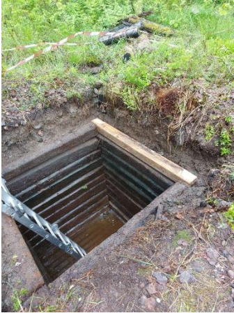
Hirsikaivoa rakennettiin viikolla 25. Kuva kaivotalkooporukalta.
