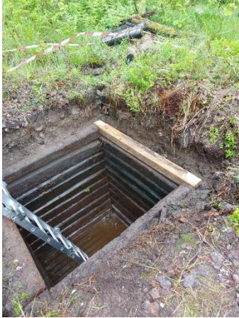
Hirsikaivoa rakennettiin viikolla 25. Kuva kaivotalkooporukalta.
